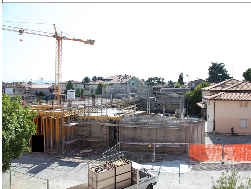
Sopra: posa in opera delle gabbie in ferro per le pareti perimetrali lato sud (19 maggio 2015); sotto: vista d'insieme dalla canonica, con gettata dei solai del 1° piano (12 agosto 2015).
