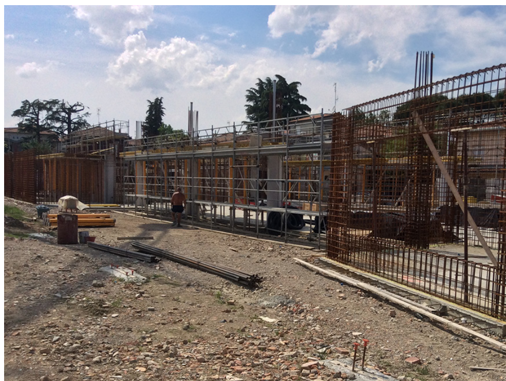
Sopra: posa in opera delle gabbie in ferro per le pareti perimetrali lato sud (19 maggio 2015); sotto: vista d'insieme dalla canonica, con gettata dei solai del 1° piano (12 agosto 2015).
